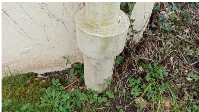
023 : Descentes Eau Pluviale fibres ciment Façade
